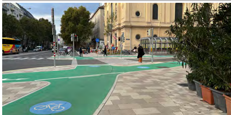
Viel Grün und Platz für Radfahrer: So sieht die neue Praterstraße aus. Der Umbau hat mehr als ein Jahr gedauert.
