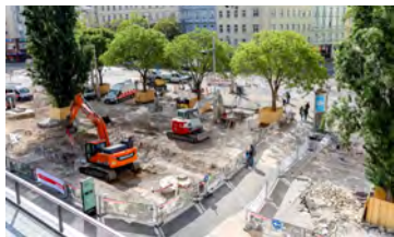
Derzeit wird am Julius-Tandler-Platz gearbeitet.
