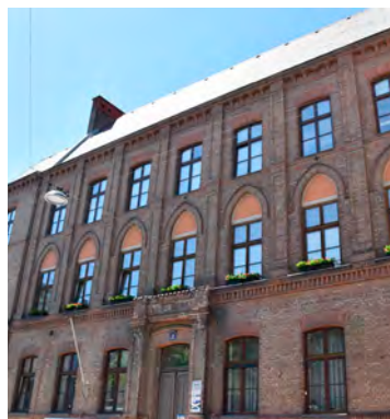
Im Amtshaus befand sich früher die Feuerwehr.
