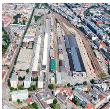
Derzeit werden alle Gebäude und Gleise entfernt.
