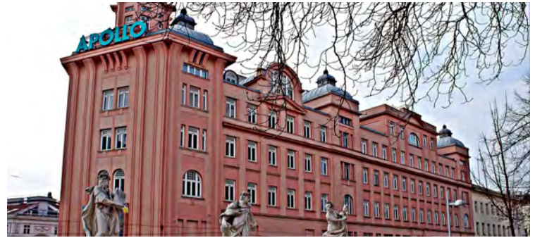
Das Apollo Kino befindet sich an der Ecke Gumpendorfer Straße und Kaunitzgasse. Es wurde als Theater im Jahr 1904 eröffnet.
