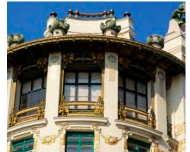
So wunderschön sieht das Dach des Majolikahauses aus.
