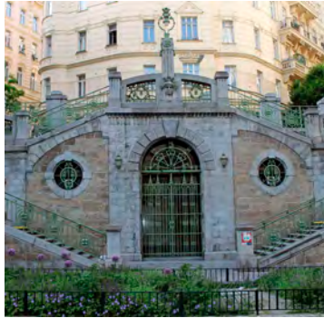
Die Fillgraderstiege wurde von 1905 bis 1907 gebaut.
