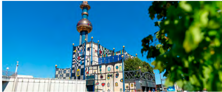
Die Müllverbrennungsanlage in der Spittelau wurde von dem Künstler Friedensreich Hundertwasser in ein Kunstwerk verwandelt.
