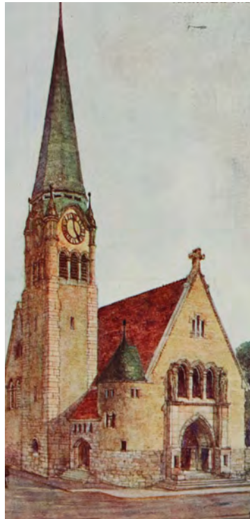
Die 1912 sich im Bau befindliche Altottakringer Kirche. Foto: Wien Museum
